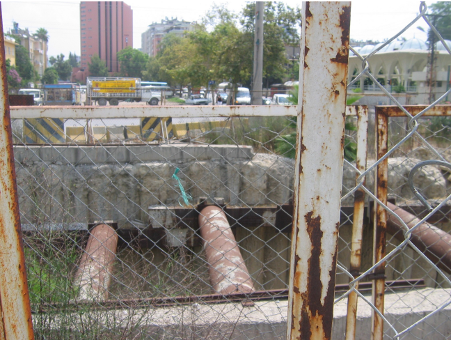
Çifte Minare önü, "Hafif Raylı Sistem" İnşaat Alanı
