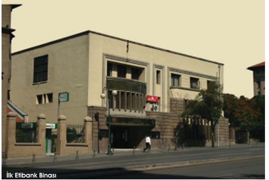
İlk Etibank Binası
