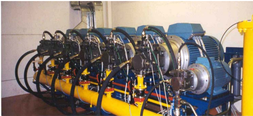
Şekil 11. Alüminyum ekstrüzyon presi pompa istasyonu pompalar
