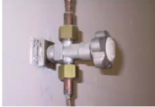
Şekil 5. Yüksek Basınç Tahliye Vanası
