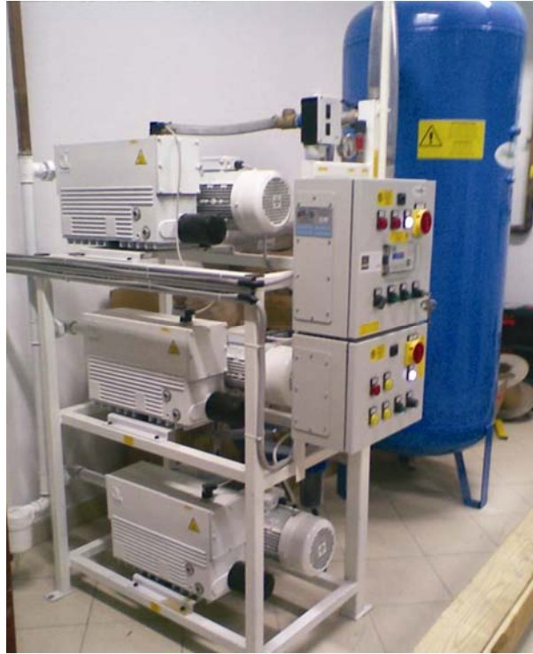
Şekil 11 Vakum Kompresörü ve Tankı
