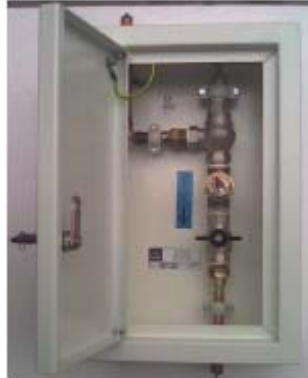
Şekil 3. Acil Basınç Düşürme Ünitesi
