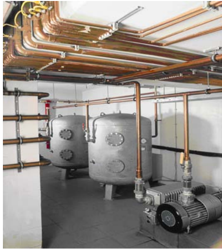
Şekil 17 Boru Hattı Destekleri
