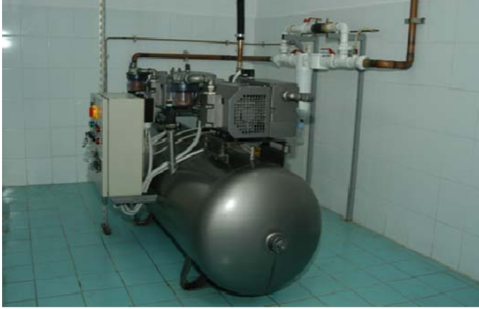
Şekil 10 Vakum Kompresörü ve Tankı
