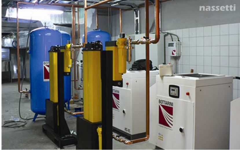
Şekil 8 Avrupa Farmacopeia Ve Uluslararası Solunabilir Hava Standardına Göre Basıncılı Hava Kompresörü, Kurutucular ve Basıncılı Hava Tankı
