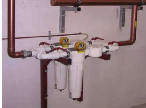
Şekil 12 Bakteri Önleyici Filtre Grubu
