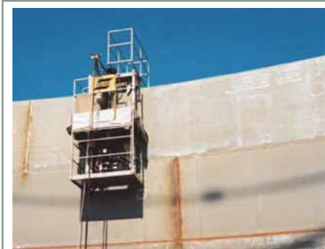
Şekil 5. %9 Ni İçeren Çeliklerin Kaynak Uygulamasına Örnek [3]
