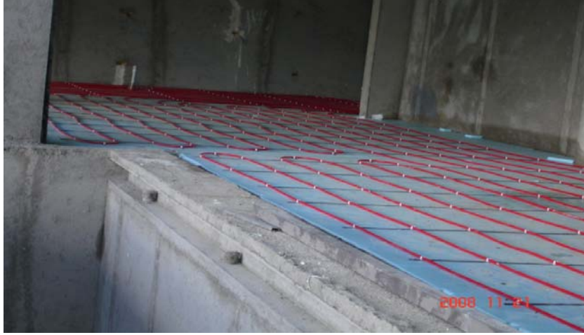
Resim 4. Kapalı Havuz Çevresi Yerden Isıtma Örneği
