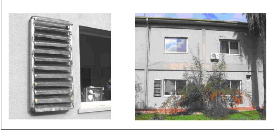
Şekil 3.4 Kolektör Buharlaştırıcı Paneli Bina Montajı
