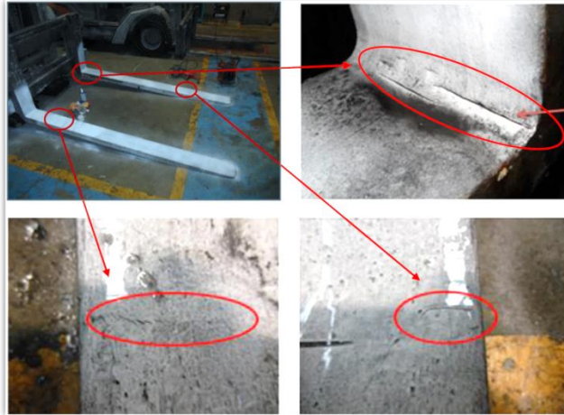
Şekil 6. Forklift Çatalında, Manyetik Parçacık Yöntemiyle Yapılan Kontrol Sonucunda Tespit Edilen Çatlaklar
