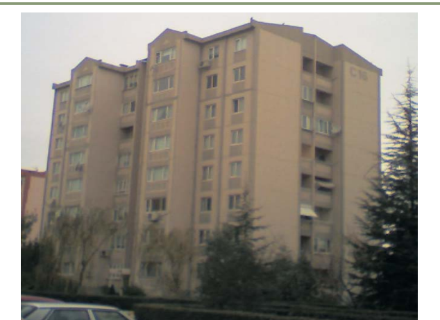
Resim 10. C16 Yalıtımsız Blok
