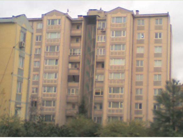
Resim 6. C16 Yalıtımsız Blok
