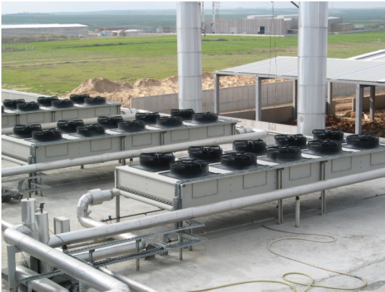
Şekil 17. Kuru Soğutucu Ünite Uygulaması [11]
