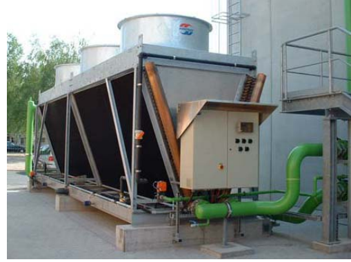
Şekil 11. Hibrid Kuru Soğutucu [15]
