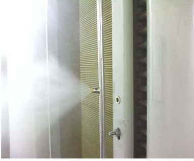
Şekil 8. Sisleme Sistemli Islak-Kuru Soğutucu [11]
