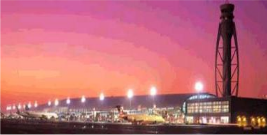
Dubai Uluslararası Havaalanı Soğutma
