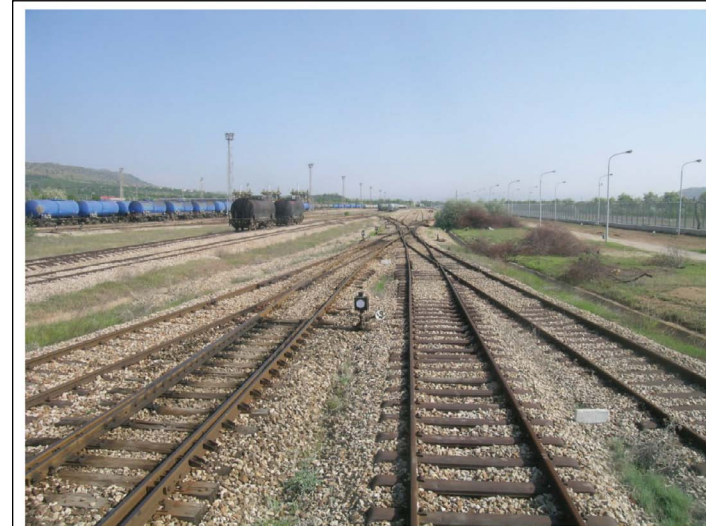
Resim 1. Tüpraş Kırıkkale Rafinerisi Vagon Dolun İltisak Hatları
