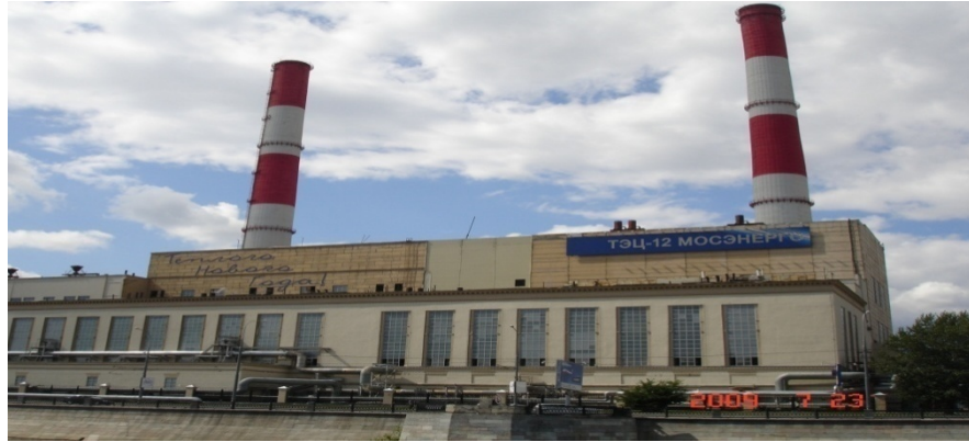
Resim 1. Bir Merkezi Isıtma Santrali
