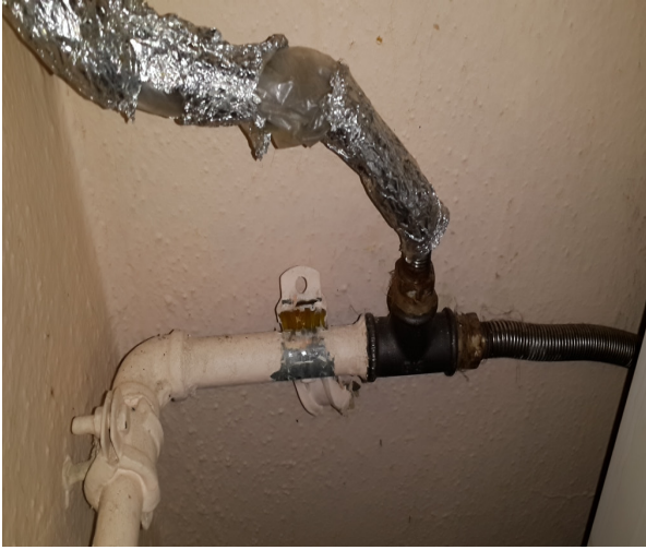
Uygun olmayan Ocak ve Şofben bağlantıları.
