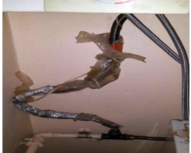
Uygun olmayan Ocak ve Şofben bağlantıları.
