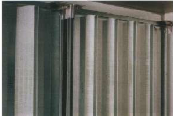
Resim 7: Filtrasyon sistemi, merkezi havalandırma cihazlarında hijyen bakımından belirleyici bir faktördür.
