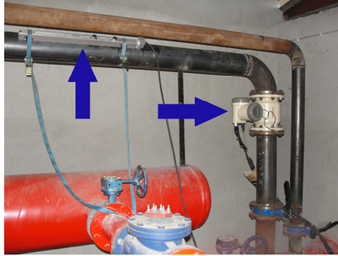
Şekil 17. By-Pass Hattı Üzerine Yerleştirilen Ultrasonik ve Manyetik Akış Ölçerler.
