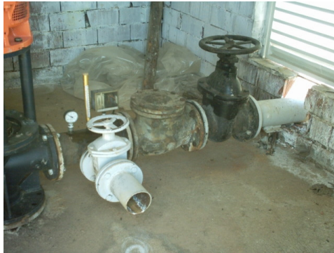
Şekil 6. Gönen JBIS'de Debi Ölçümlerine Elverişsiz Bir Kuyu Başı Tesisatı.
