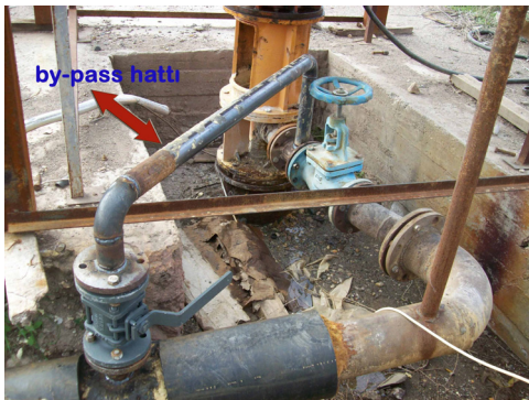
Şekil 9. Bigadiç JBIS'de Bulunan HK-6 Kuyu Başı Tesisatına Yapılan By-Pass Hattı ve Bu Hat Üzerinde Ultrasonik Debi Ölçüm Çalışması.
