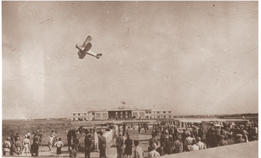
Nu.D.36 ve Yeşilköy'deki Hangar
