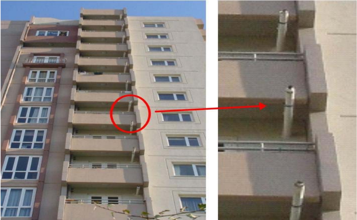
Şekil 2. Yüksek Bir Yapıda Hermetik Kombi Baca Bağlantısı (Balkon Çıkışı)
