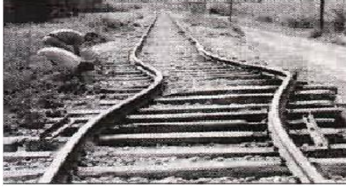
Resim 3. Yanlış Montajın Sebep Olduğu Malzeme Termal Genleşmesi [3]
